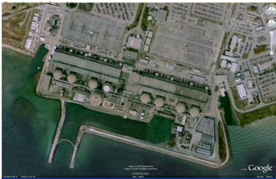
Image satellitaire de la centrale Pickering (Image : Avec la permission de Google Earth )
